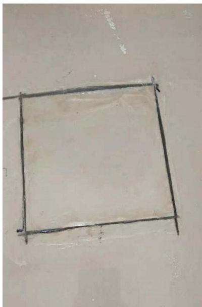
危废暂存间地漏封堵
