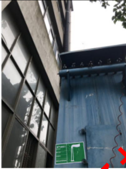
P1排气筒废气排放口环保标识
