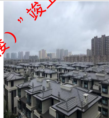
居民油烟排放口
