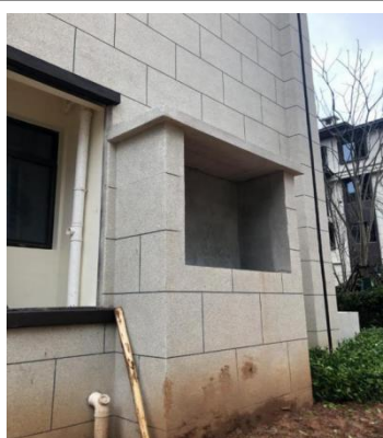
地下车库出气口
