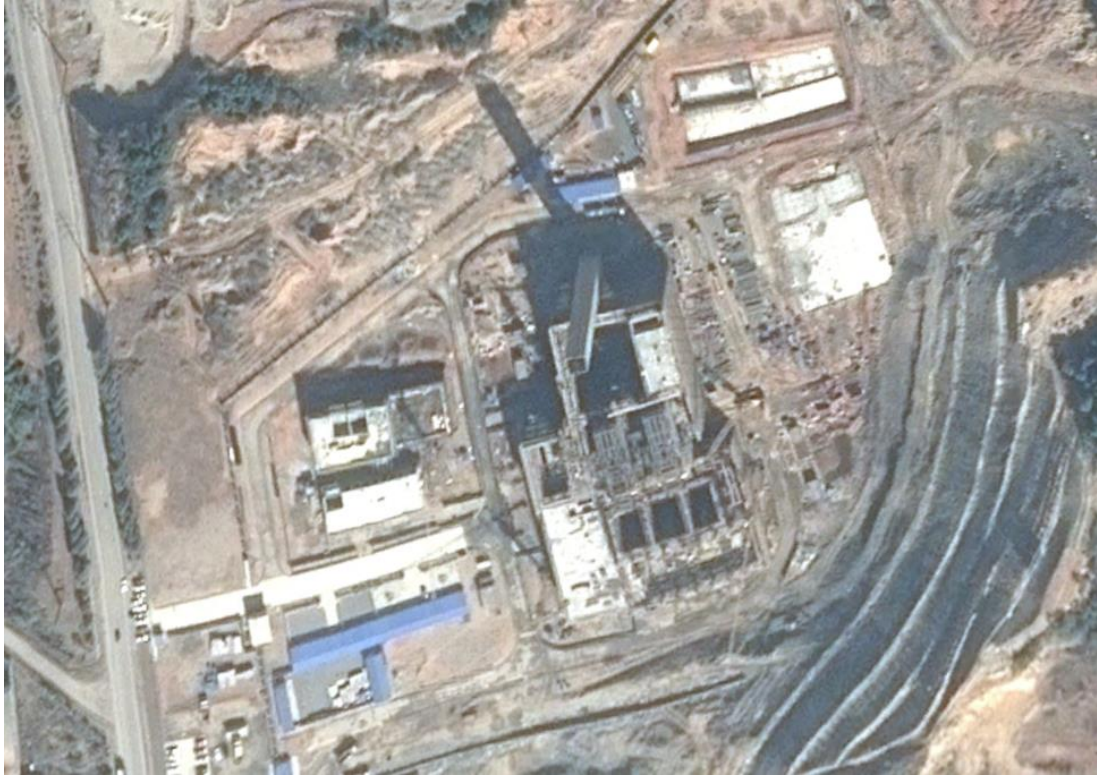
2017年2月施工现状图
