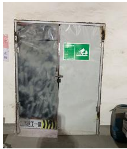
一般固体废物暂存处
