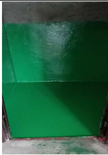
危废间地坪漆
